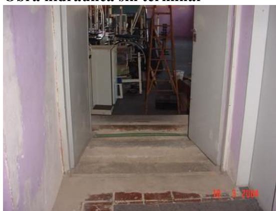
Obra hidráulica sin terminar
